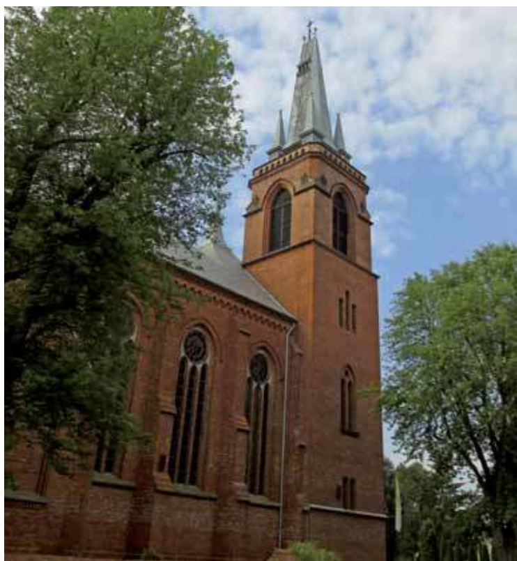
Parafia w Popowie Kościelnym (gm. Somianka) wykonała prace remontowo-konserwatorskie na wieży kościelnej (fot. arch. UMWM)
