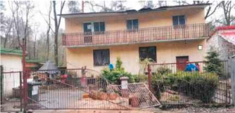
Przez zbyt wąską ulicę Bór w połowie kwietnia br. strażacy mieli problem z dotarciem z pomocą mieszkańcom, na których dom zawalił się okazały dąb
