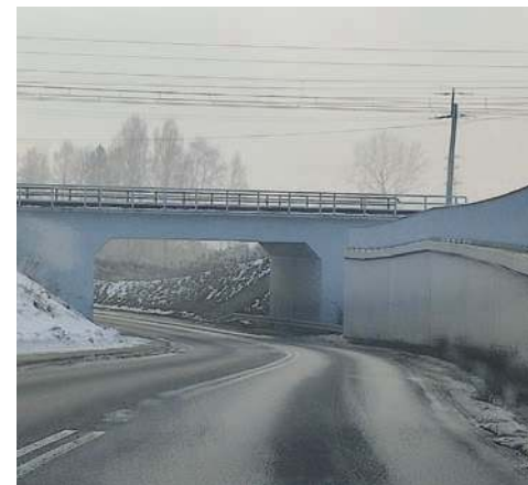
Nieoświetlona ul. Styczniowa przy wiadukcie kolejowym w Luszowicach
