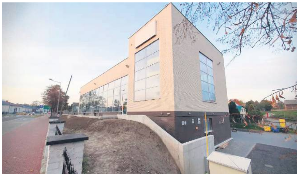
Niedługo minie rok od zaplanowanego na marzec 2022 terminu otwarcia Krytej Pływalni w Hrubieszowie.
