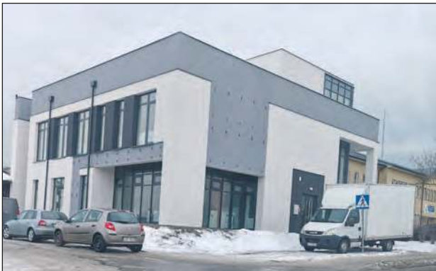
Budowa budynku biurowego przy ulicy Słowackiego w Rykach należącego do PGKiM ruszyła dwa lata temu. Od 29 stycznia swoje urządowanie tu rozpoczęło Biuro Terenowe ZUS
