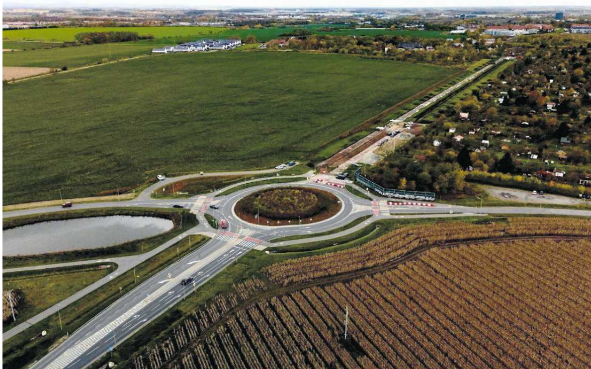
• Do ukończenia budowy WOW pozostał ostatni odcinek, ale istotny, bo prowadzący przez miejscowość Wysoka do ul. Karkonoskiej i węzła przy autostradzie A4 w Bielanych Wrocławskich FOT. MATERIAŁY PRASOWE
