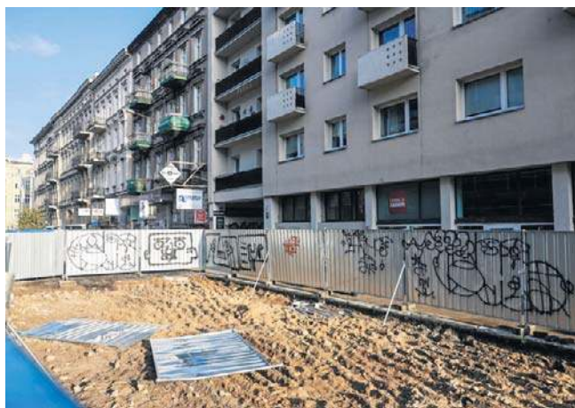
Tak obecnie wygląda ulica Ratajczaka w Poznaniu. Jest wyłączona z ruchu, ale nie ma jej ekipy budowlanej
