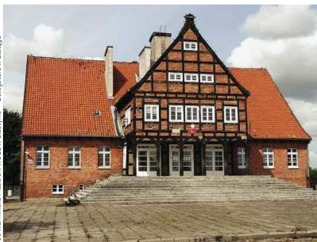
Szkoła w Zwierznie (gm. Markusy), dawny Dom Ludowy. Zabytek z lat 30. XX w. zaprojektowany na wzór żuławskich domów podcieniowych doczeka się remontu dachu i wymiany instalacji elektrycznej
