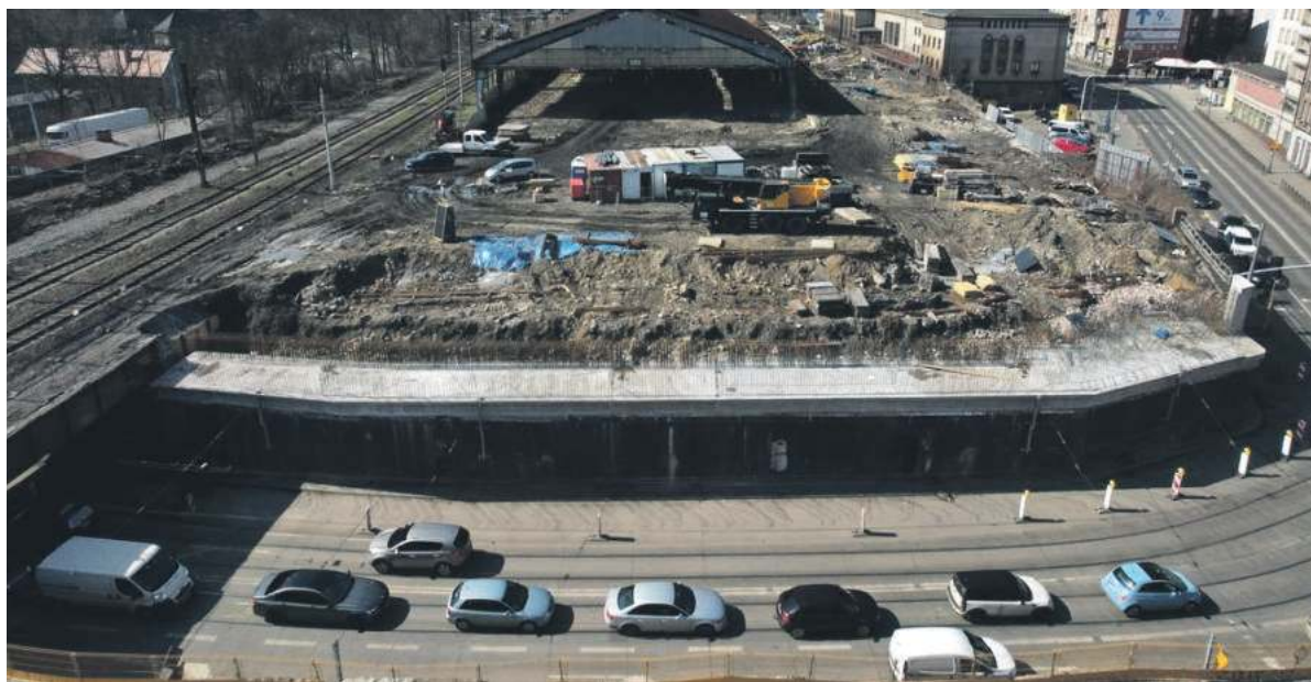
Stary wiadukt zniknął niemal w całości
