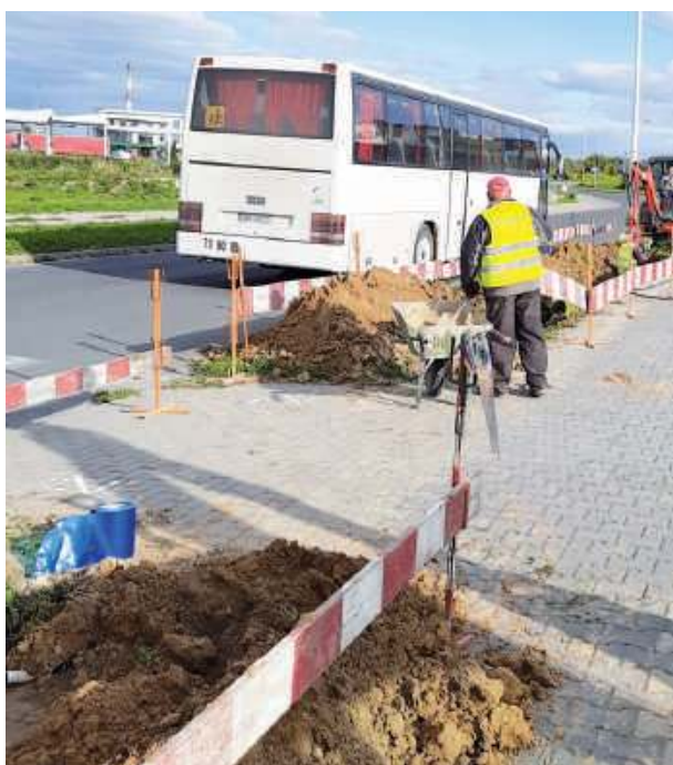
Układanie kabla na ul. Zamoyskiego.
