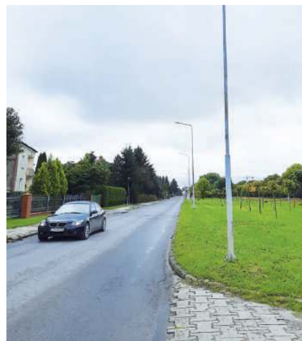
Ul. Promienna – wymienione oprawy oświetlenia ulicznego.
