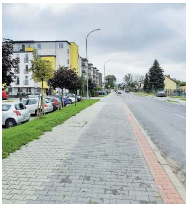
Ul. Młyńska – wymienione oprawy oświetlenia ulicznego.
