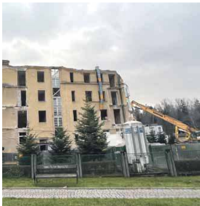
Budynek szpitala zostanie rozebrany do parteru.
