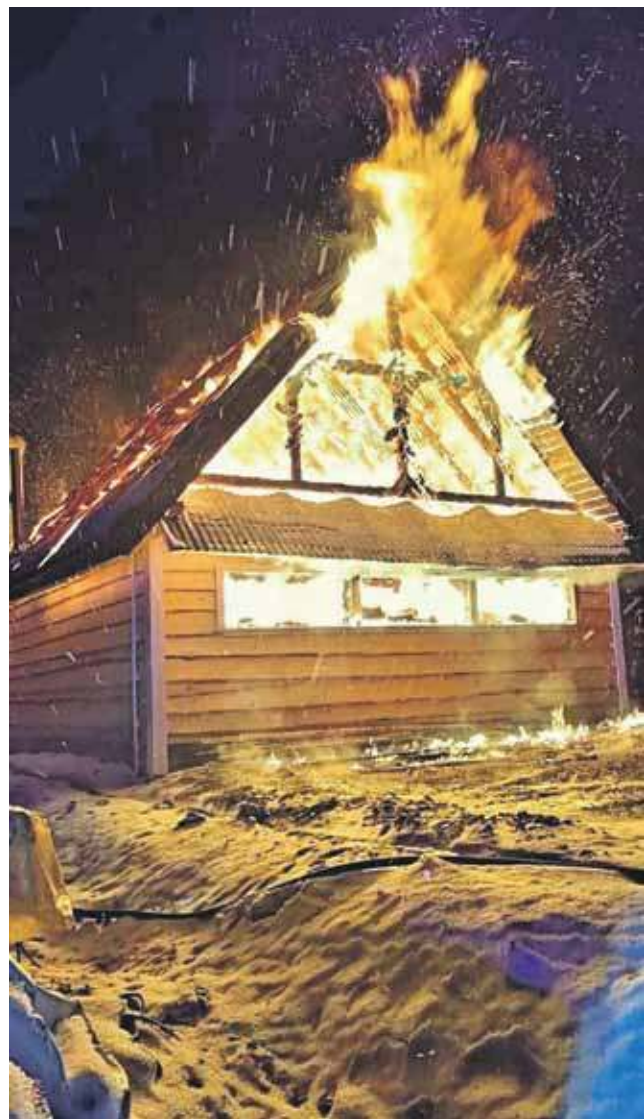
Gdy strażacy przybyli na miejsce, budynek stał już w ogniu.
