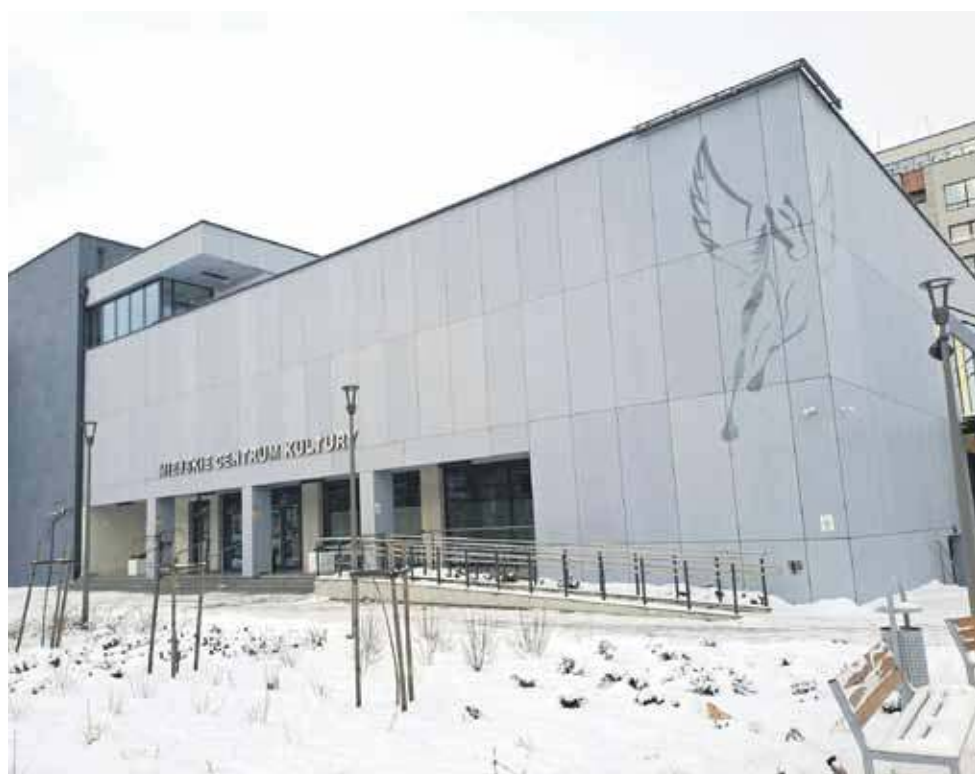
Czy budynek MCK już wymaga remontu?
