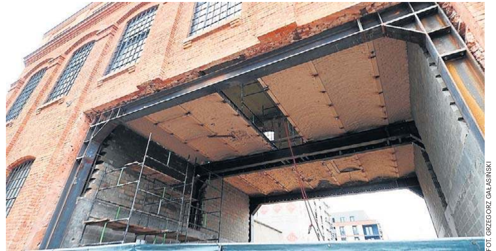
Budynek dawnej suszarni fabryki Geyera z wyciętym otworem na nową ulicę
