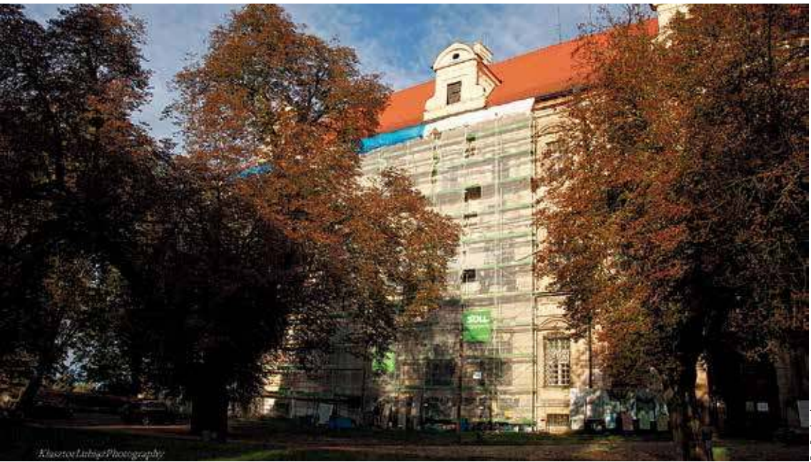
Remont elewacji Klasztoru w Lubiążu
