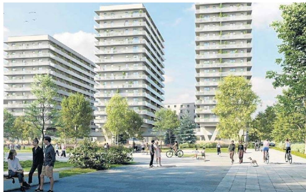
Był dworzec, będą wieżowce. W centrum Katowic rusza budowa kompleksu mieszkaniowego „MIKATO”
