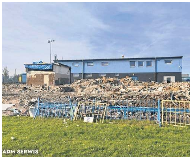
Prace rozbiórkowe na Cichej ciągle trwają. Równocześnie powstaje koncepcja nowego stadionu Ruchu Chorzów
