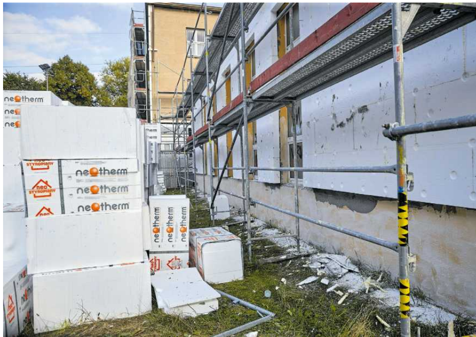
• Termomodernizacja szkoły przy ul. Szpitalnej w Łodzi FOT. MARCIN STĘPIEŃ / AGENCJA WYBORCZA.PL
