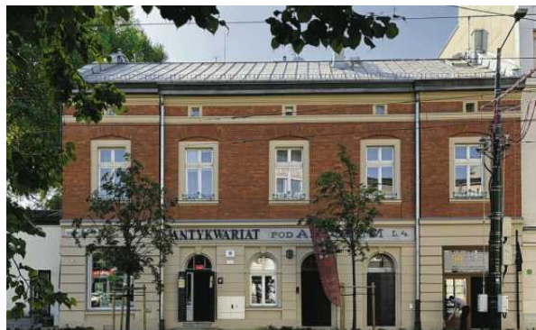
Kościuszki 18 - po termomodernizacji - fot. ZBK
