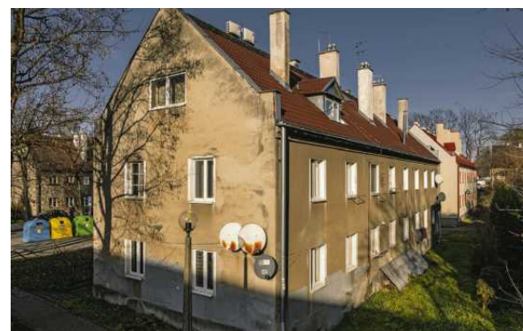
Dworcowa 9 - przed termomodernizacją - fot. P. Krzan
