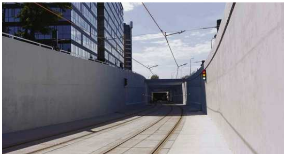
Wylot z tunelu od strony Ronda Barei fot. Łukasz Pacholczyk
