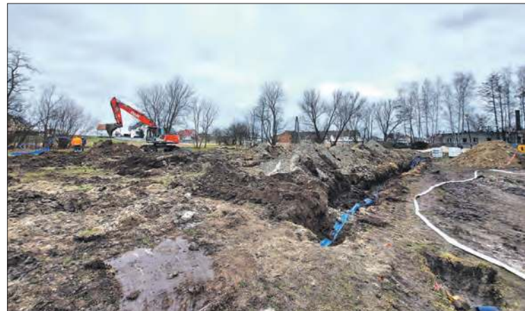
Wielki plac budowy
