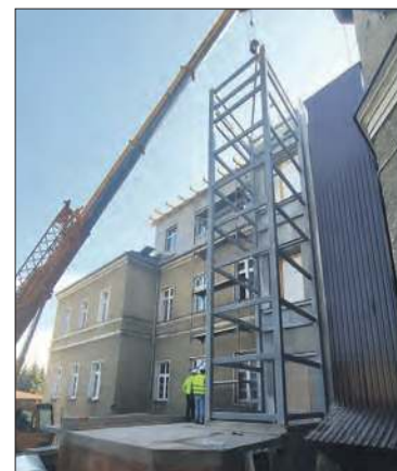
Montaż szybu windy
