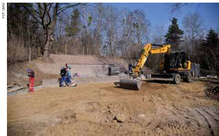
Budowa sceny plenerowej w Klonowie
