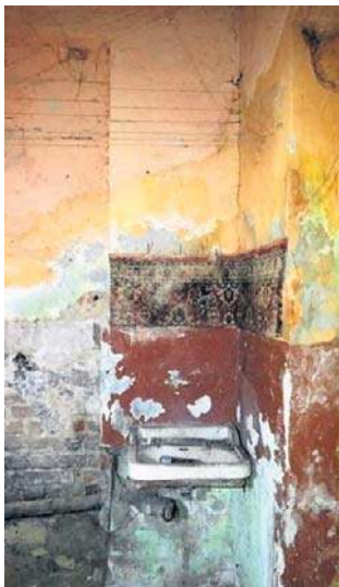
W kamienicy są dwa opuszczone lokale
