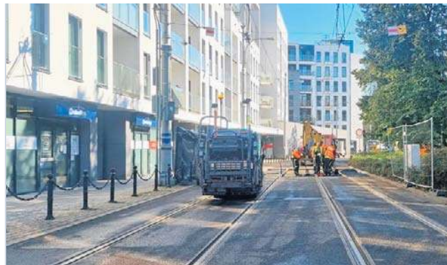
Na ulicy Dowbora-Muśnickiego naprawiono torowisko i kanalizację pod nim. Prace trwały ponad tydzień
