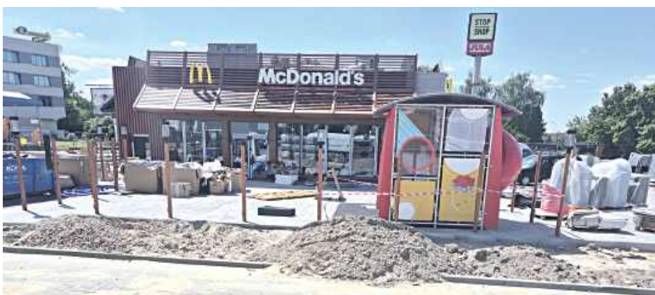
Budynek McDonald's przy ulicy Turystycznej już stoi, trwają jeszcze prace na zewnątrz obiektu
