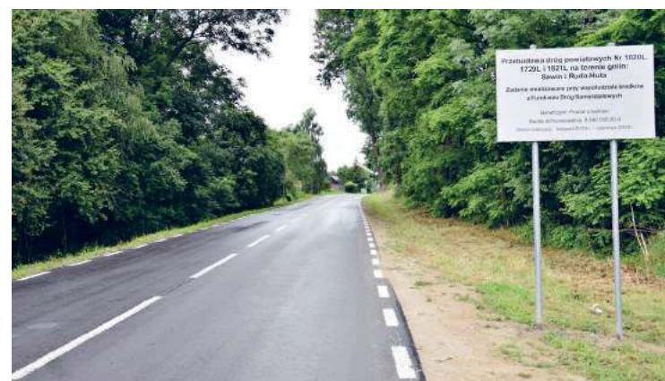
Przebudowa dróg powiatowych na terenie gmin Sawin i Ruda-Huta
