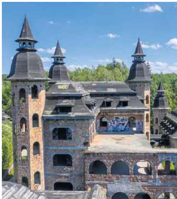
Zamek w Łapalicach - potężna ruina
