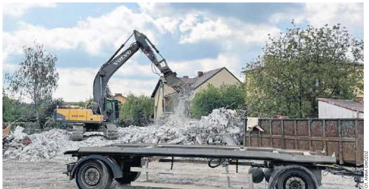
Ciężki sprzęt kruszy beton i zbrojenia. Tak wygląda jeden z pierwszych widocznych etapów przygotowania terenu pod budowę S74
