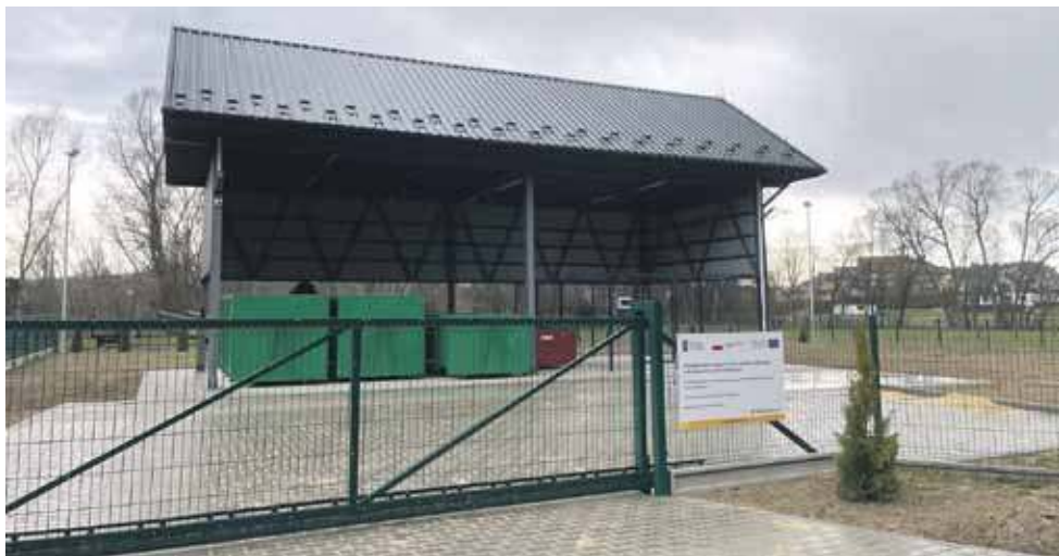
Instalacja powstała w sąsiedztwie oczyszczalni ścieków.
