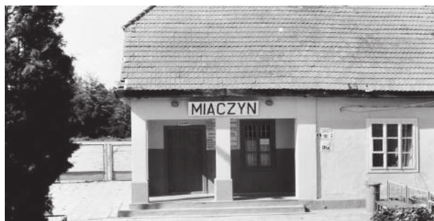
Budynek dworca w Miączynie rozebrano kilkanaście lat temu. Fot. Miłosz Telesiński-Zbąszynek
