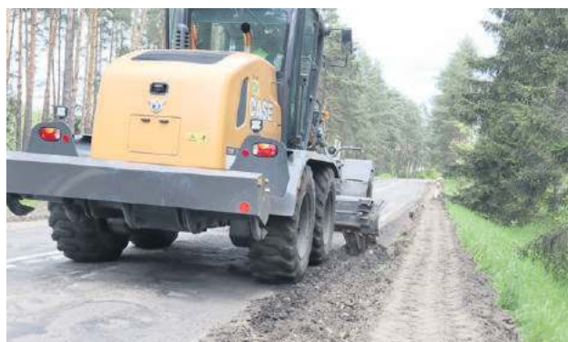
Na terenie powiatu biłgorajskiego drogi wojewódzkie poddawane są gruntownej przebudowie w trzech miejscach.
