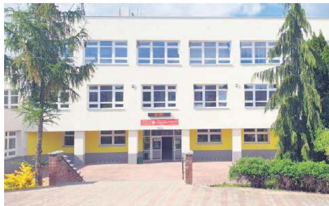
Budynek ZSP nr 3 po termomodernizacji.
