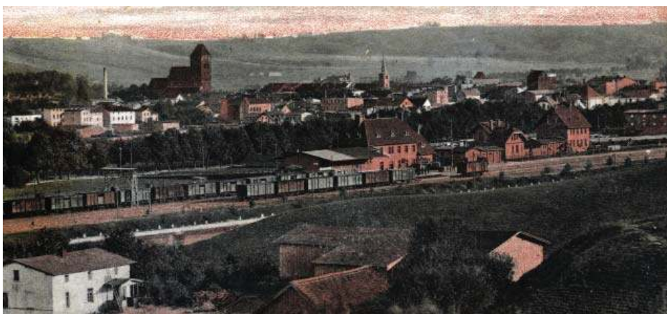
Stacja kolejowa w Nowym Mieście zajmowała się ruchem pasażerskim i towarowym
