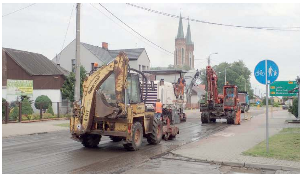
Remont nawierzchni ulicy Kościelnej
