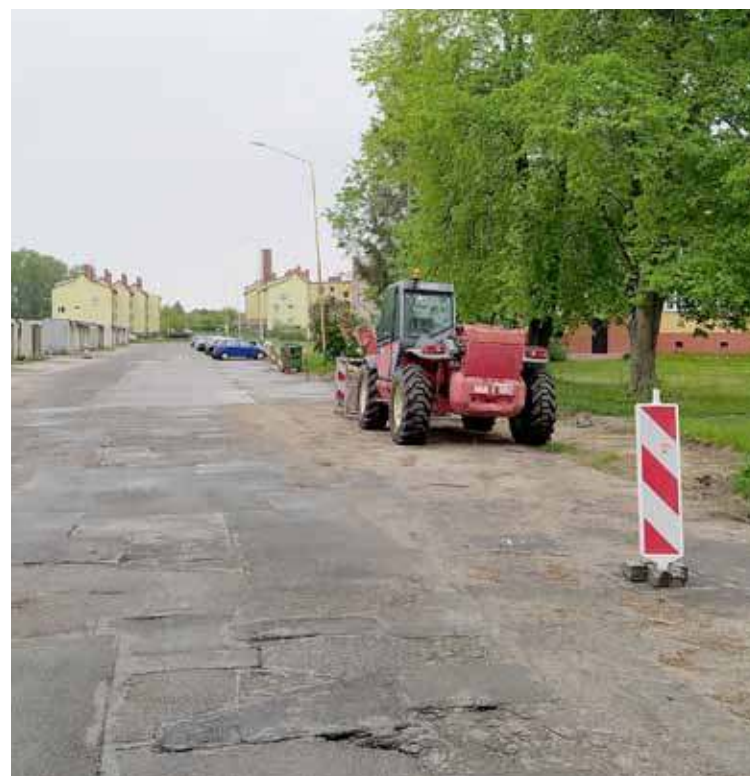
Na miejscu pojawił się nawet ciężki sprzęt i oznakowanie terenu
