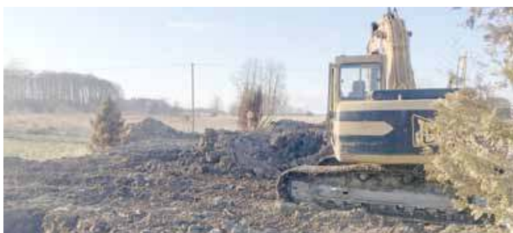
Prawidłowo wykonane prace ziemne są podstawą założenia dobrze funkcjonującego ogrodu
