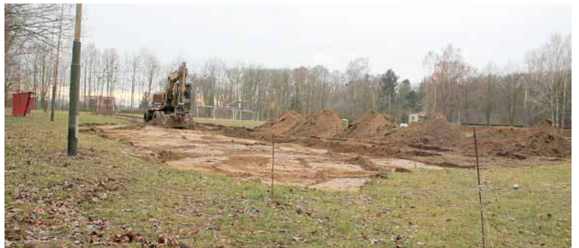
Prace rozpoczęto z początkiem tygodnia od ściągania humusu
