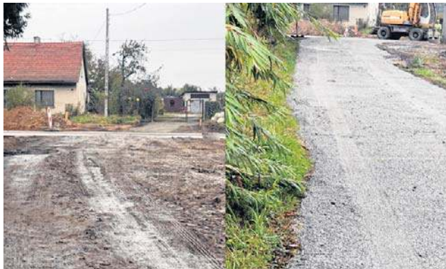
Po naszej interwencji, droga została tymczasowo utwardzona grysem i śmieciarka może już odebrać śmieci
