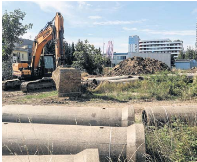
Na działce przy al. Kopisto prowadzone są prace przygotowawcze pod inwestycję
