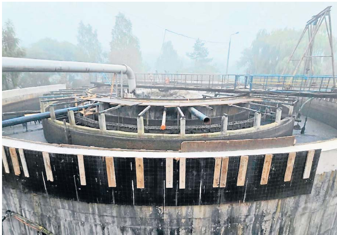
Jeden z osadników wtórnych pracuje już w ramach prowadzonego procesu technologicznego. Wokół zbiornika trwają prace przy instalacjach i wyposażeniu.
