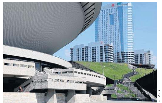
Remont tarasów i schodów katowickiego Spodka będzie kosztował miasto kilkadziesiąt milionów złotych
