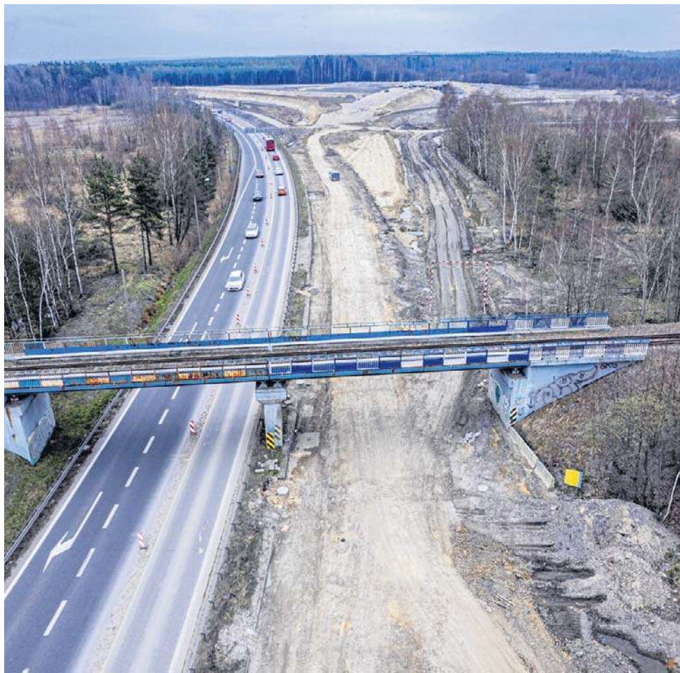
GDDKiA umożliwiła w marcu przejazd nadal powstającym odcinkiem w Bieruniu
