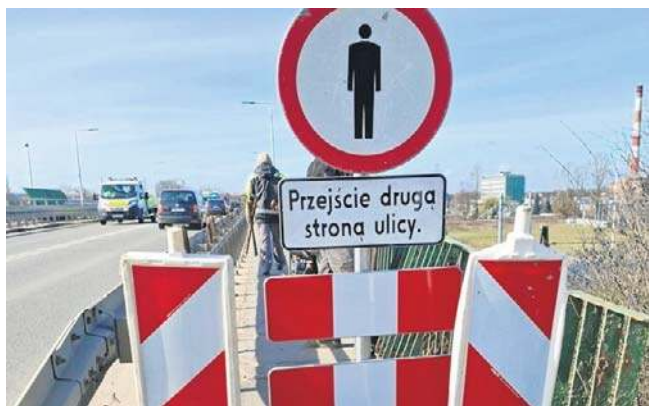
ZDW zapowiada, że wiadukt ma zostać rozebrany, a w jego miejscu powstanie nowa konstrukcja
