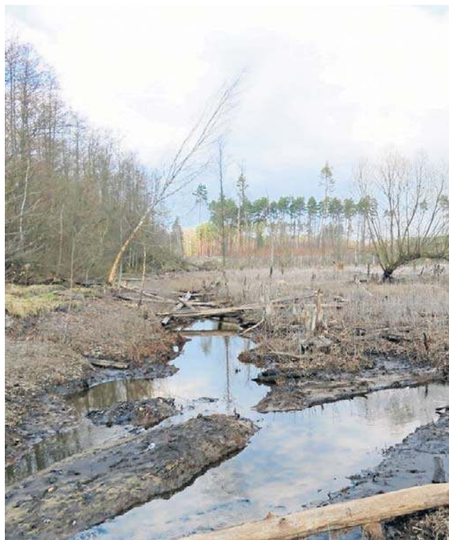
Teren po rozbiórce
