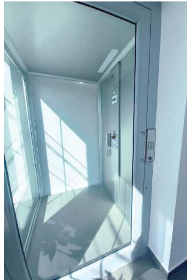
W budynku zamontowano windę
