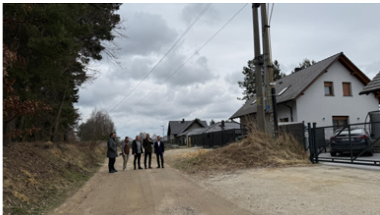
Ulica Akacyjowa przed remontem.
