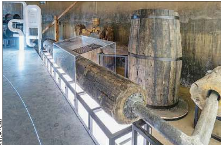
Fragment jednej z najstarszych sieci wodociągowej na terenach dzisiejszej Polski eksponowanej na historycznym szlaku wodnym w Gdańsku.
