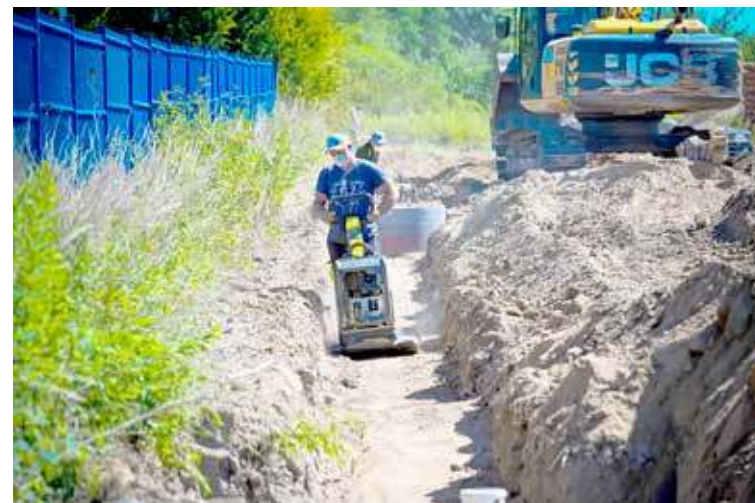
Początek prac na kolejnym odcinku obwodnicy północnej. Fot. Sebastian Ler
