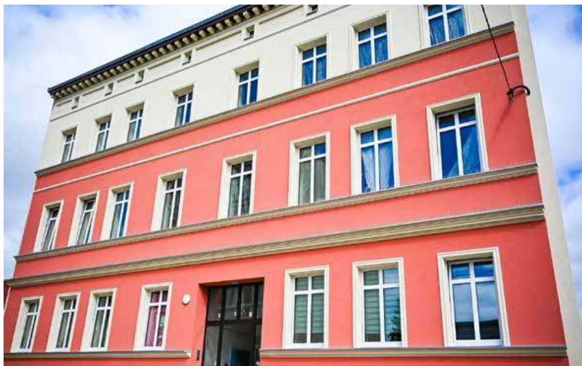
Tak wygląda elewacja odnowionej kamienicy przy ul. Młyńskiej. Fot. Sebastian Ler
