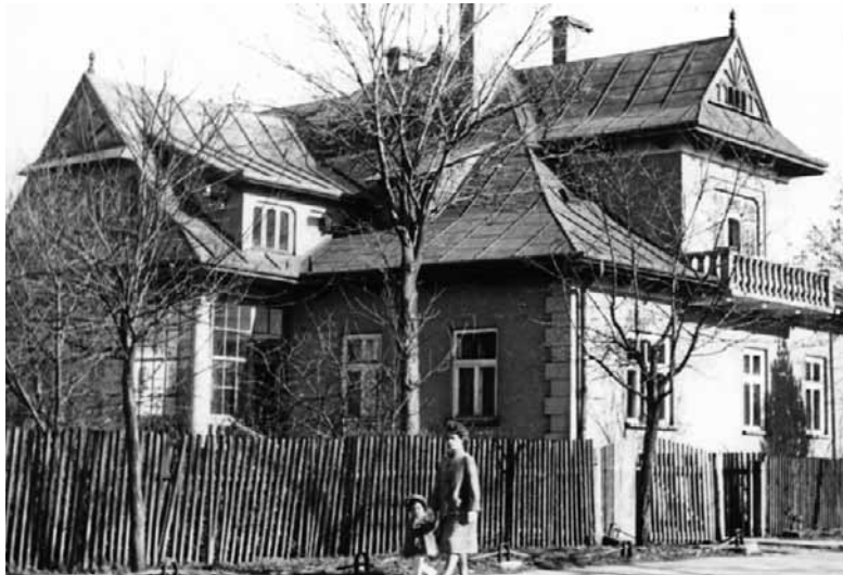
Budynek, w którym mieścił się Powiatowy Urząd Bezpieczeństwa Publicznego w Nowym Targu
