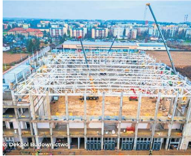
Arena Świdnik nabiera już kształtów. Gdy szkielet hali zostanie zabudowany, ruszą prace wewnątrz obiektu
