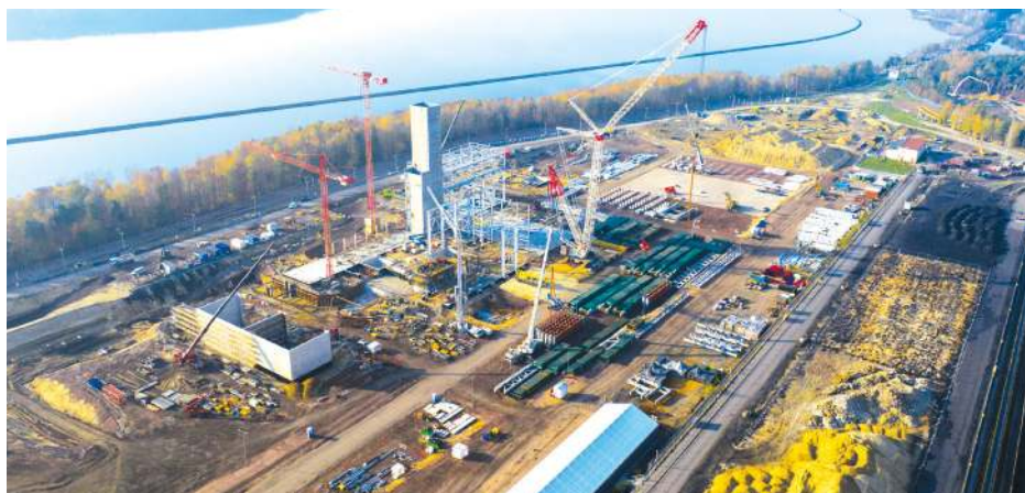
Nowo budowany blok gazowo-parowy w Rybniku
