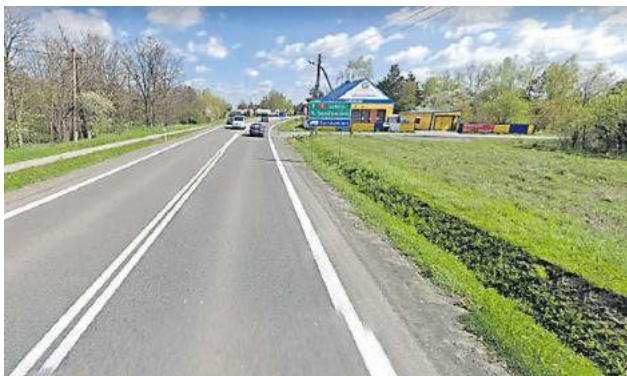
Bezpieczne przejście dla pieszych ma powstać przy ulicy Gruntowej
