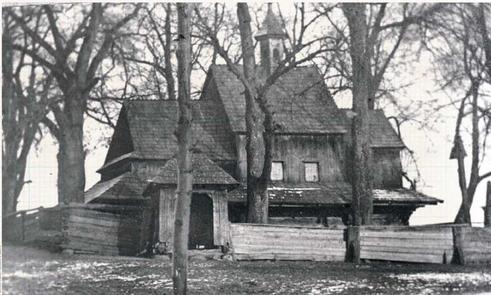
Nieistniejąca cerkiew unicka w Majdanie Starym
