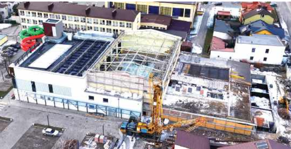
Plac budowy na „starej części”
