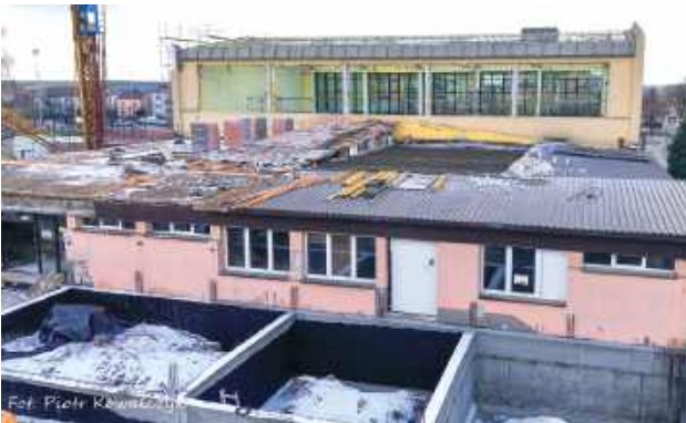
Na starej części basenu trwają prace budowlane
