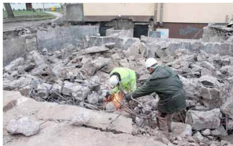
Pracownicy wycinają elementy zbrojeniowe dawnego składu węgla
