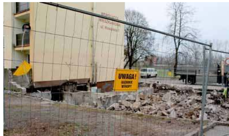
Teren prac ogrodzono, powieszono też tablice ostrzegające o niebezpieczeństwie
