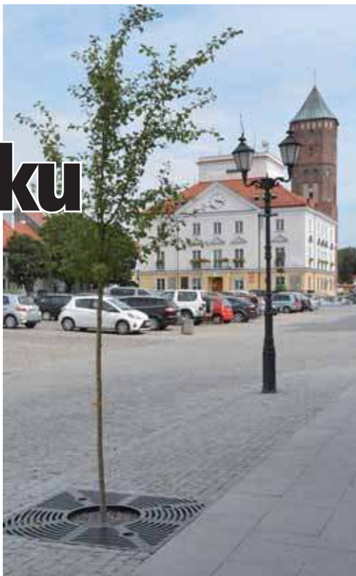
IK Widok na ratusz i wyremontowaną część rynku
