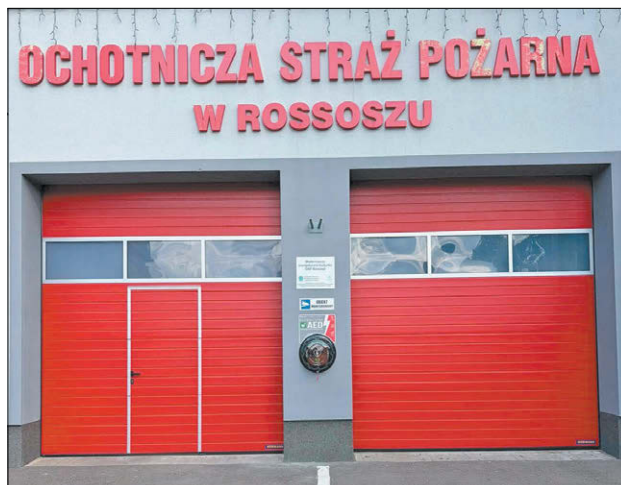
Jest pod ręką i może uratować życie. Nowy defibrylator zainstalowano przy remizie OSP w Rossoszu
