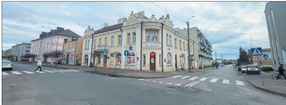
– Wykonawca nie rozpoczął realizacji robót budowlanych na ul. Chomiczewskiego oraz ul. Warszawskiej z przyczyn obiektywnie niezależnych od miasta Radzyń Podlaski ani od wykonawcy – informuje wiceburmistrz Bożena Lecyk
