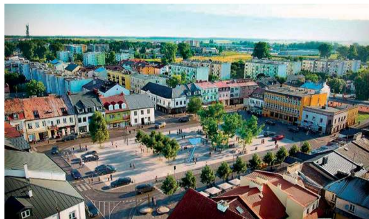
Część kamienic przy płońskim rynku doczeka się renowacji
