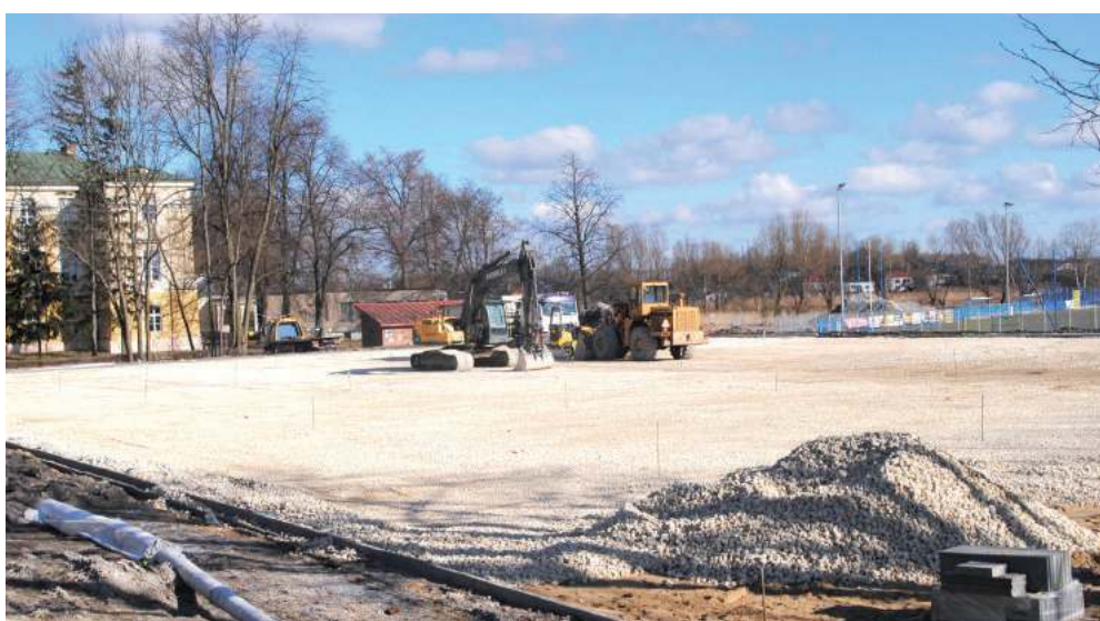
Prace na budowie postępują. Wykonany został już drenaż płyty boiska. Aktualnie – jak podają urzędnicy – trwa wykonywanie warstwy konstrukcyjnej pod projektowaną nawierzchnię ze sztucznej trawy. Kładziona jest warstwa kruszywa naturalnego. Prowadzone są również prace związane z budową oświetlenia
