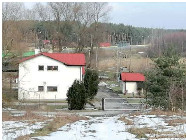
Chodelska oczyszczalnia ścieków liczy sobie ponad dwadzieścia lat. Odkąd została wybudowana, nie przechodziła gruntownej modernizacji
