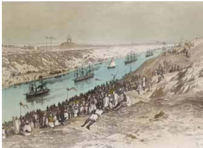
Budowa Kanału Sueskiego.
