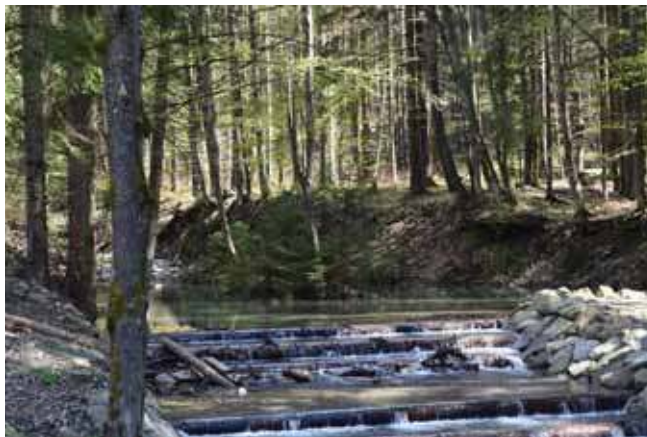
Sztuczne piętrzenia zmniejszające spadek wody na potoku Urwisko
