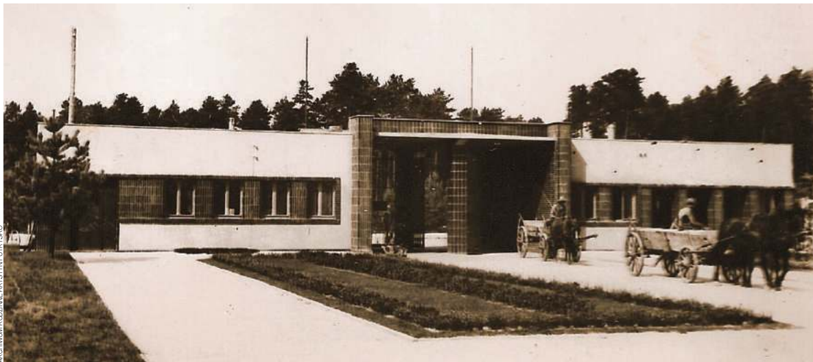
Portiernia główna Zakładów Południowych (1939 r.), widok na elewację południową
